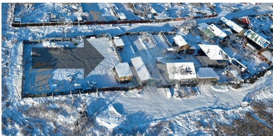
Рис. 4. Земельный участок с нарушением
