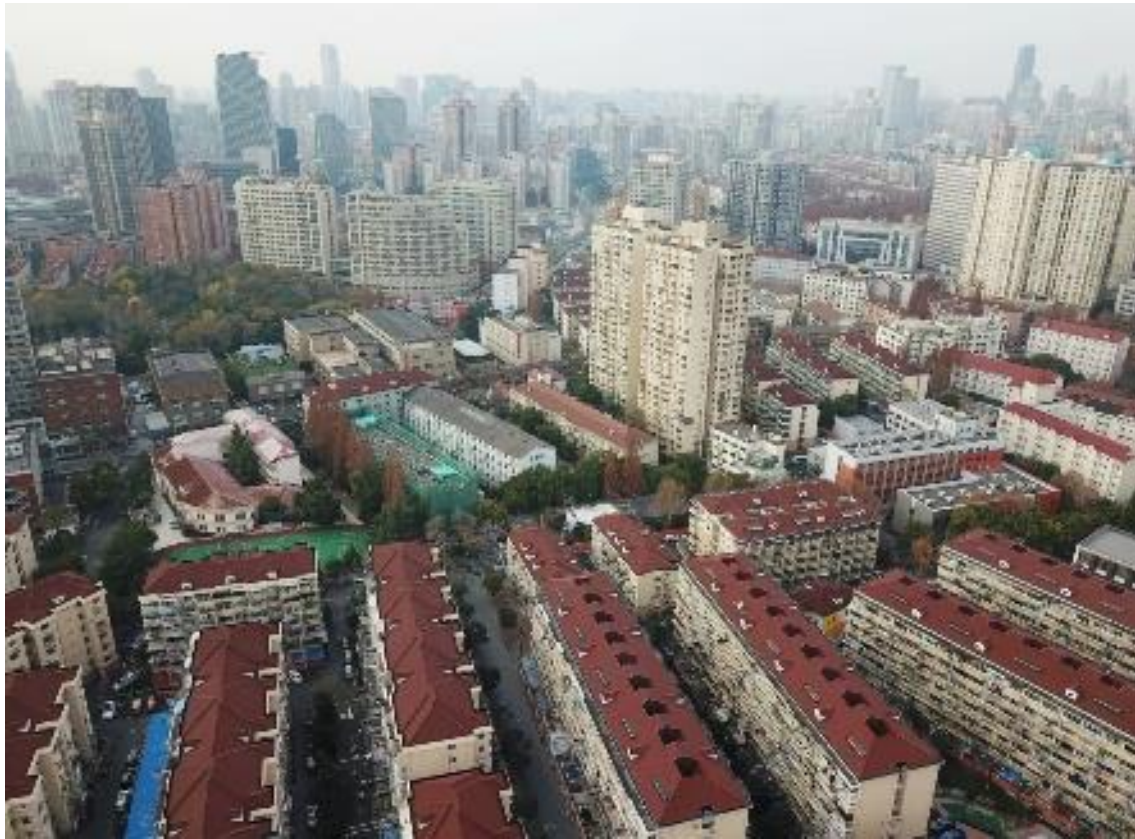
Рис. 9. Район Лэшань до ремонта. На заднем плане – центр Сюйцзяхуэй
