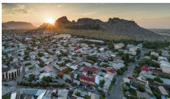
Рис. 1. Строительство домов в городе Ош до 2015 года
