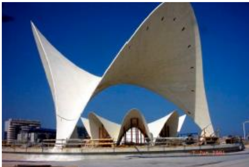
Рис. 6. Готовая конструкция оболочки покрытия
