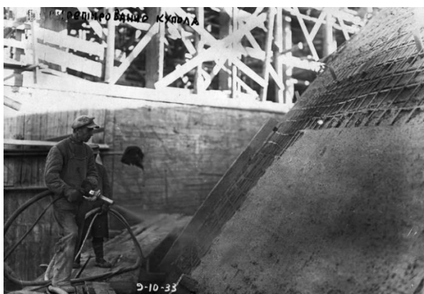
Рис. 8. Торкрет бетонирование оболочки купола (информация о методе торкретирования отсутствует)
