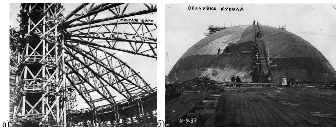
Рис. 7. Опалубочные работы при сооружении купола а – устройство подмостей с применением деревянной башни и ферм; б – укладка досок настила
