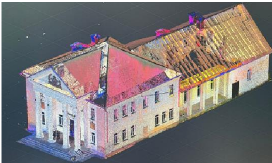
Рис. 1. Лазерное сканирование аварийного здания районного дома культуры
