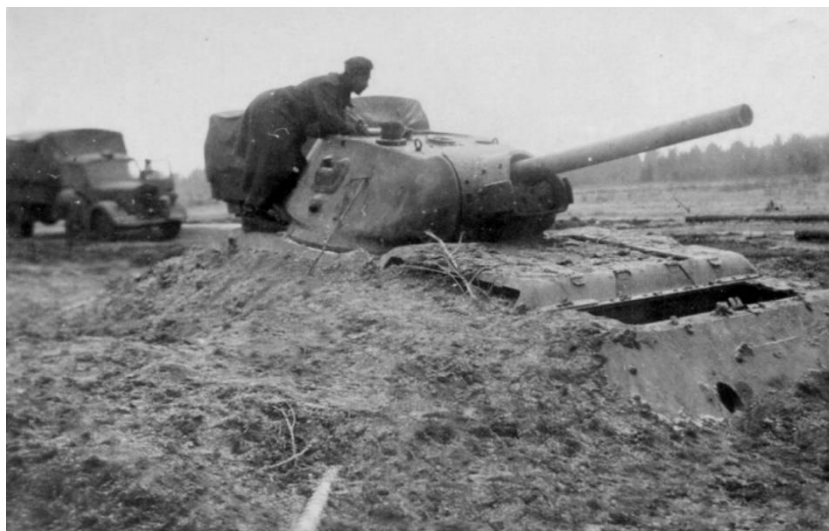
Рис. 2. ТОТ из танка Т-34-76, октябрь 1941. Из машины перед установкой вынут двигатель.
