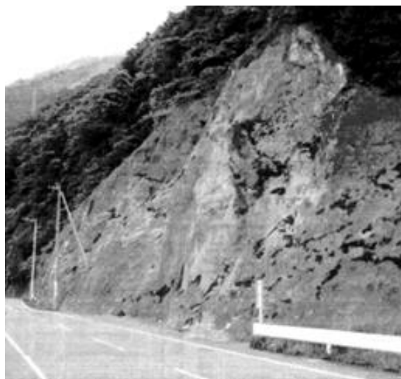
Рис. 1. Склон дороги, укрепленный сталефибробетоном [2]
