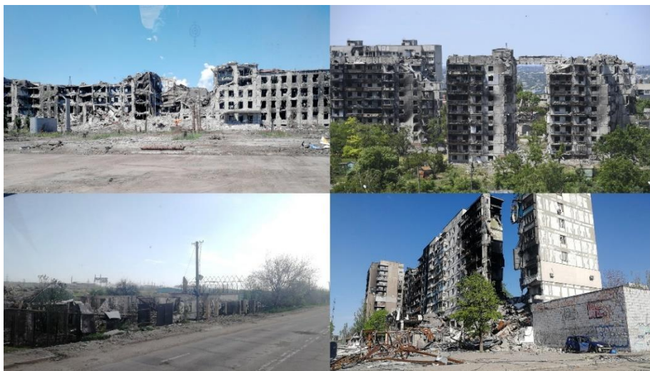
Рис. 1. Разрушения зданий в г. Мариуполь
