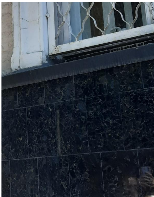
Рис. 7. Фрагмент фасада, отделанного искусственным камнем
