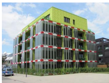
Рис. 1. BIQ Das Algenhaus, Am Inselpark 17, Гамбург, Германия. Спроектирован Splitterwerk Architects
